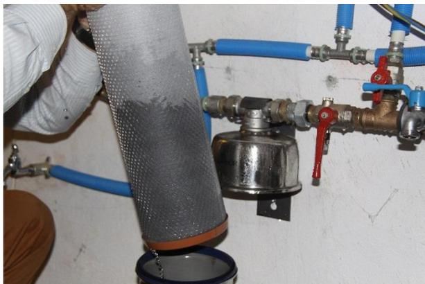
Drene el agua del fondo de la carcasa del filtro Aquaphor (el agua puede ser negra debido al carbón activado que sale del filtro que ya no está bajo presión o marrón si hay oxidación en las tuberías galvanizadas de la compañía de distribución de agua de la ciudad = óxido de hierro):
