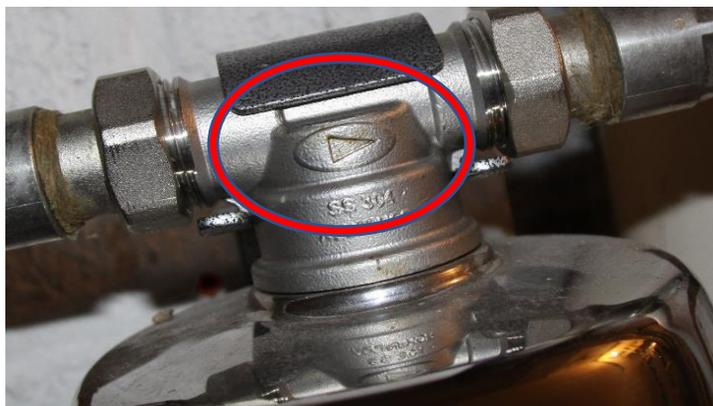
Sens de l'écoulement de l'eau
