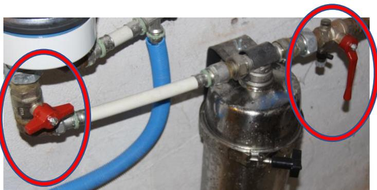
Vannes en amont-aval du Biofiltre
